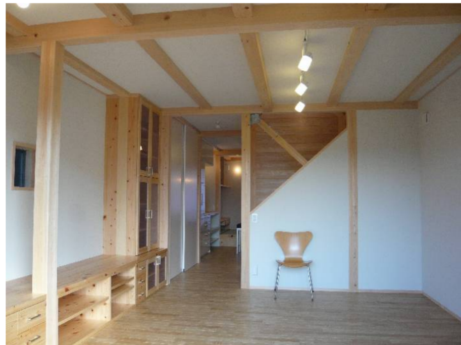
柱・梁を表した内観
