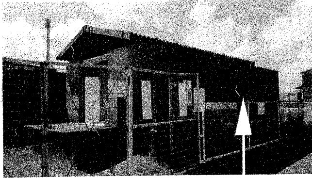
違法なブロック塀の、宮下住宅プロパン庫
