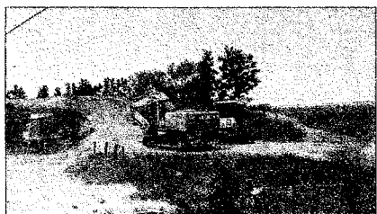
埋め立てが始まった川口町防災拠点施設
