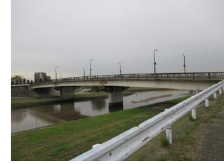
現在の逢妻川橋
