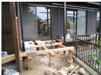
製材した板の大きさは、幅140mm、長さ1100mm、厚さ50mm、枚数52枚でした。
