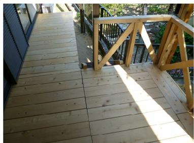
が出てしまう状態でした。（約1年乾燥させた板は少し湾曲、又、板厚が上下差異発生）しかし後悔しても仕方ないと思い、コツコツと状況に合わせて作業をやっていく中でだんだんコツもわかり調子も上がってきました。
