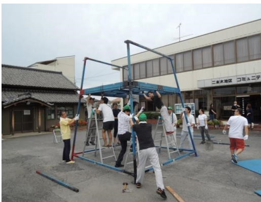
「安全第一」櫓の組み立て。
