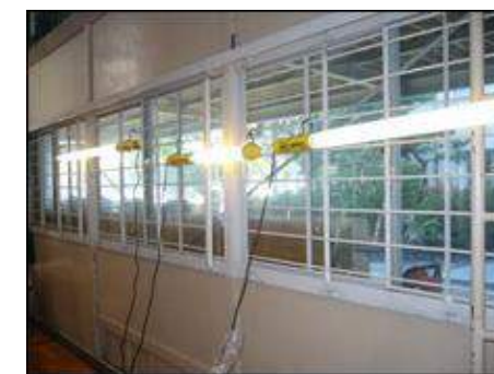
小型発電機による照明セット
