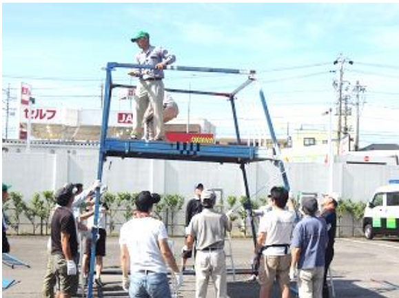
「安全第一」櫓の組み立て。
