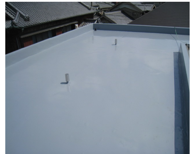
⑥ トップコート塗布 施工完了
