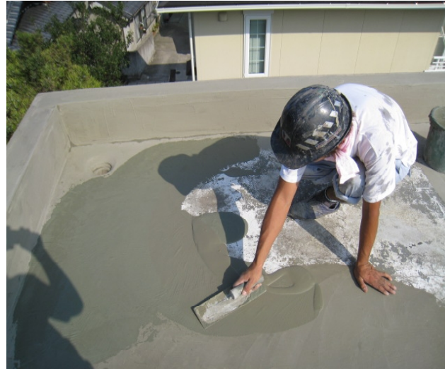
② 下地処理 全面樹脂モルタル掛け
