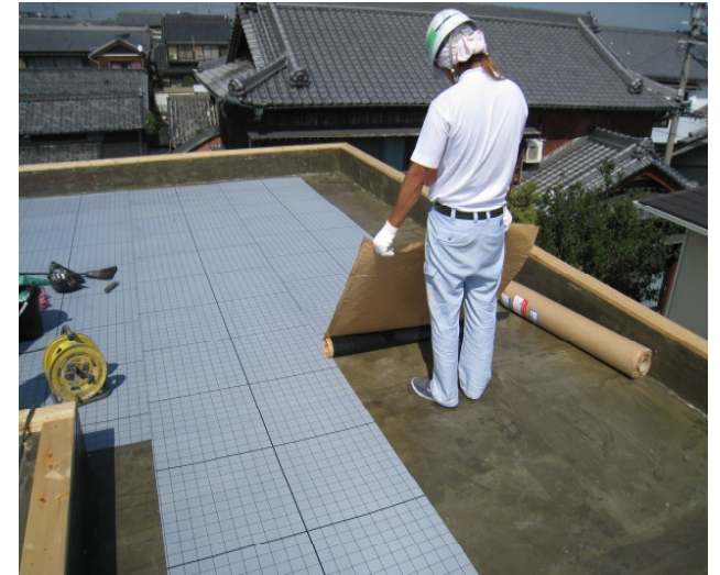
③ 通気緩衝シート張り付け
