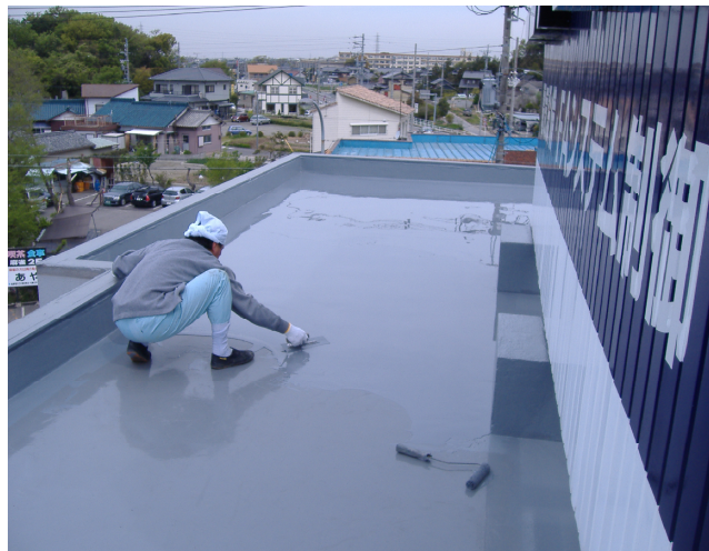
⑤ ウレタン防水塗布 (2回塗り 3.8kg/m 2 )
