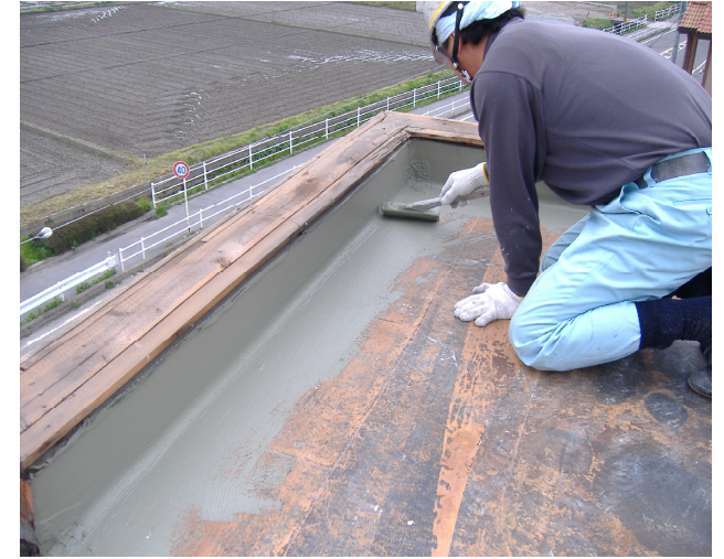
⑥ 仕上げトップコート塗布完了
