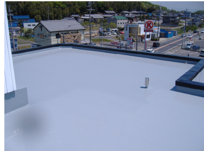
⑥ 仕上げトップコート塗布完了
