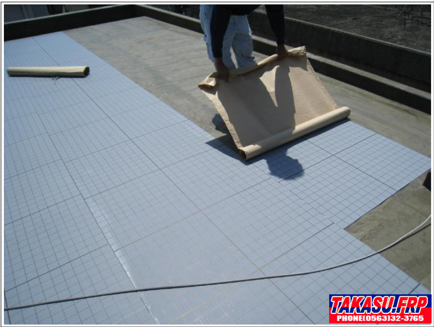
床面 通気緩衝シート貼着
