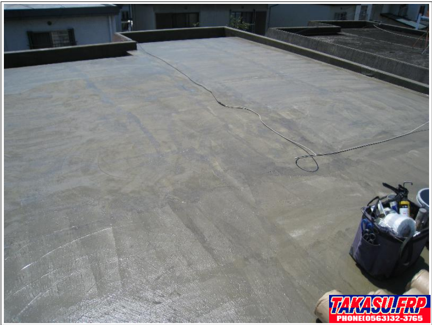
プライマー塗布 完了
