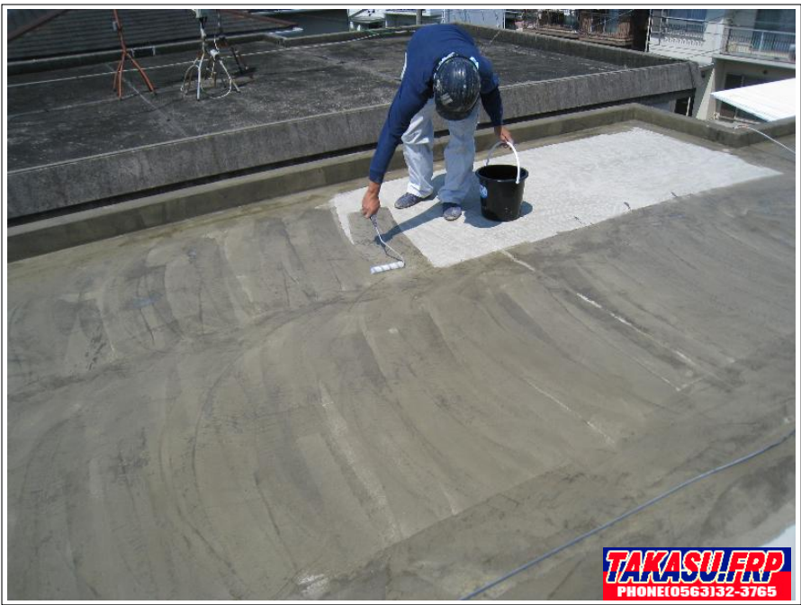
プライマー塗布
