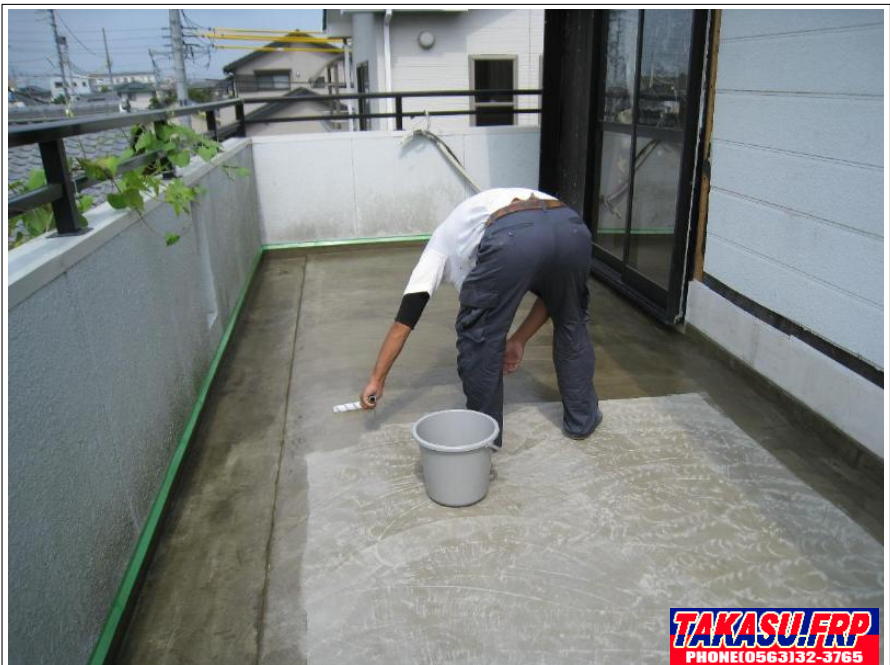
プライマー塗布
