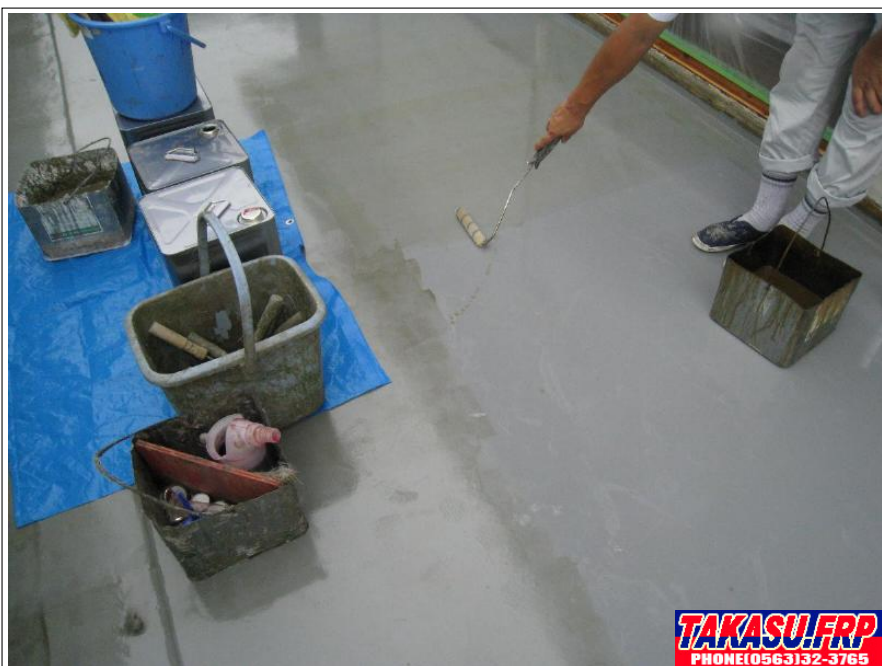
FRPプライマー塗布
