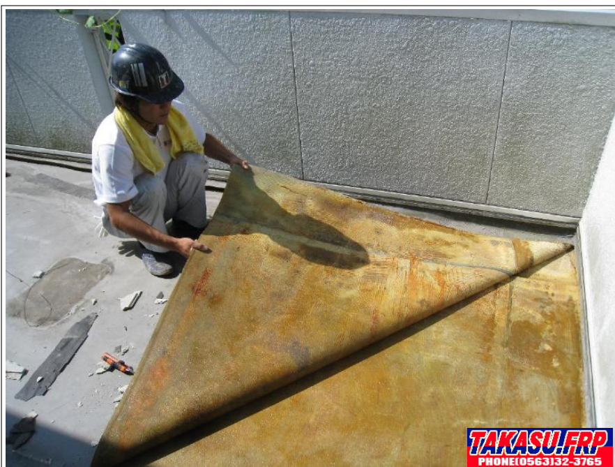
既存防水撤去
