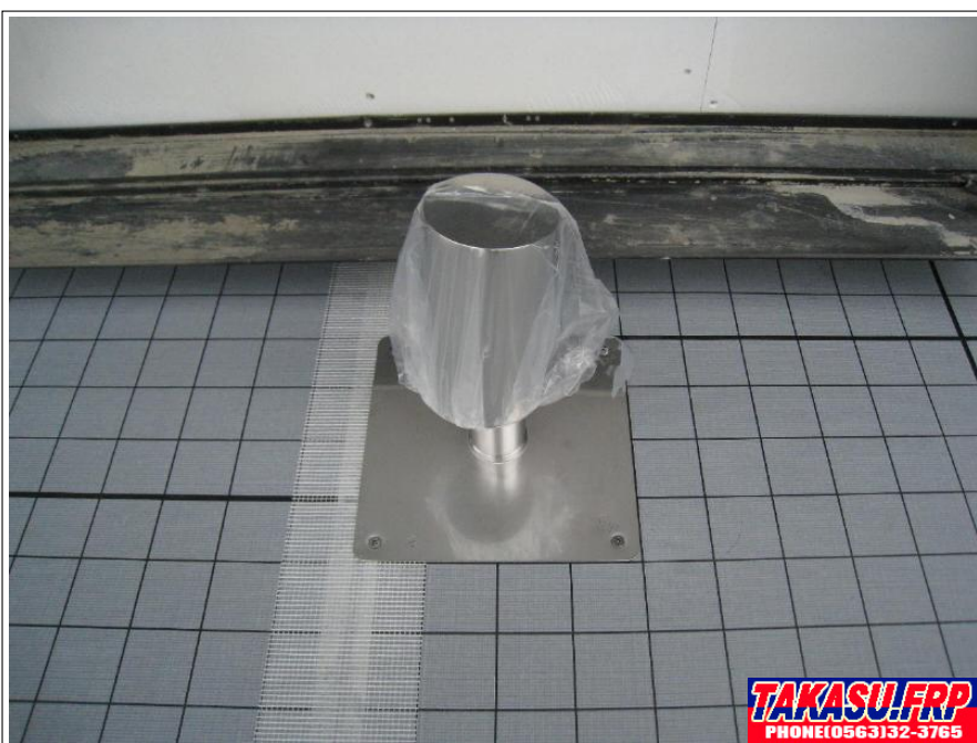
脱気筒取り付け
