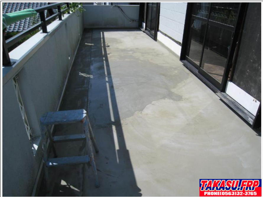
下地処理 完了
